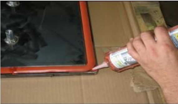
Renforcement des angles avec du silicone haute température
