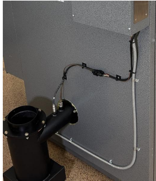
Fils du capteur O2 et du thermocouple
