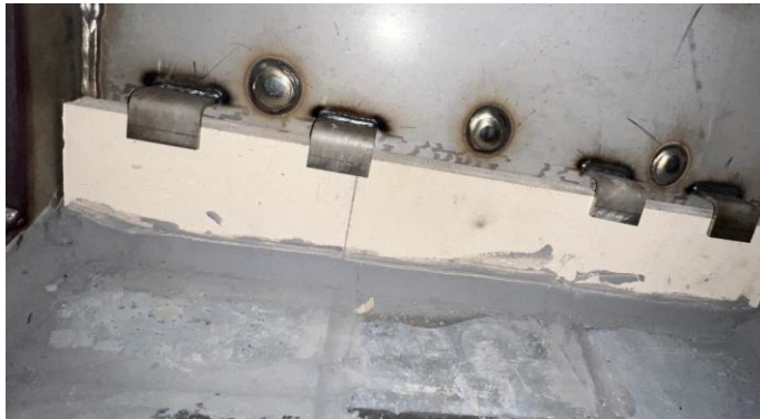
Mur latéral Firebick Mortored
