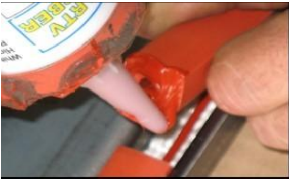
Ajout de silicone haute température à la jonction bout à bout d'un bourrelet découpé
