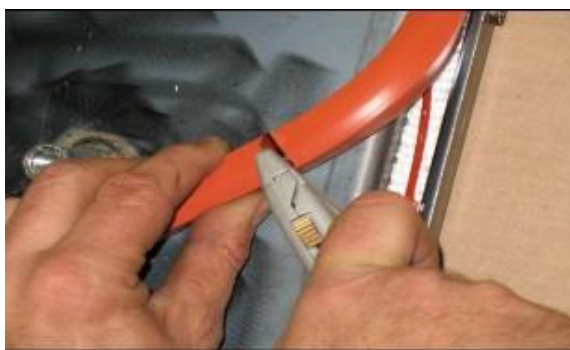
Découpage des perles de silicone préformées
