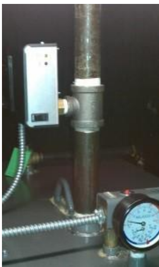
Phot o : Installation de la coupure d'eau
